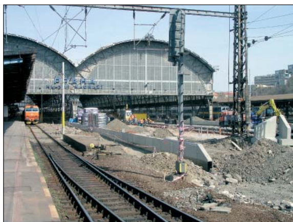
Rekonstrukce III. a IV. nástupišť Hlavního nádraží
