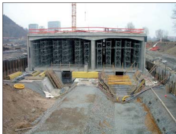
Stavební práce na Městském okruhu v Troji
