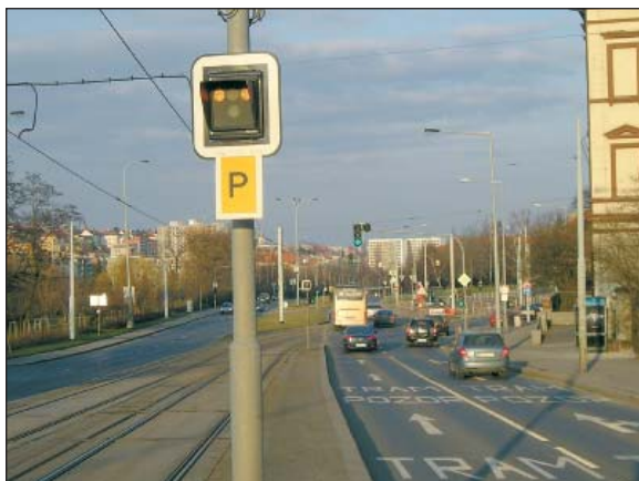
SSZ 6.144 Bělohorská – Patočkova s předsignálem pro tramvaje
