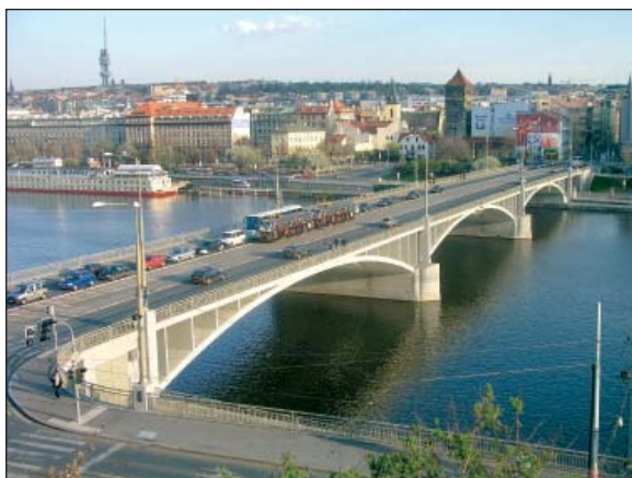
Zrekonstruovaný Štefáníkův most
