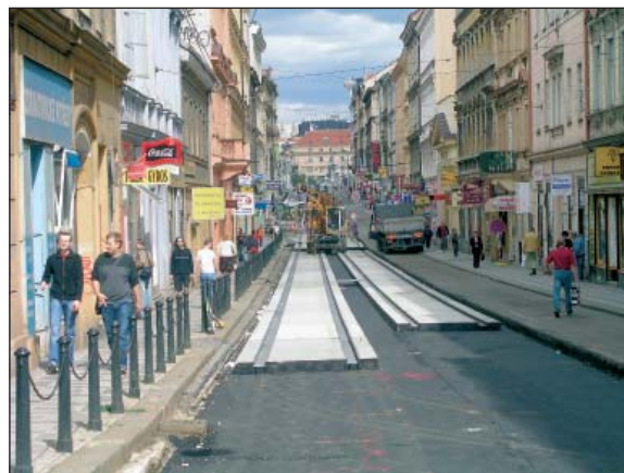
Začátek opravy křižovatky na Palackého náměstí a výměna panelů BKV na tramvajové trati v Lidické ulici
