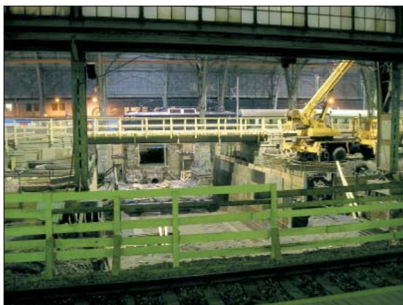
Výstavba nových podchodů a rekonstrukce III. a IV. nástupiště na pražském Hlavním nádraží
