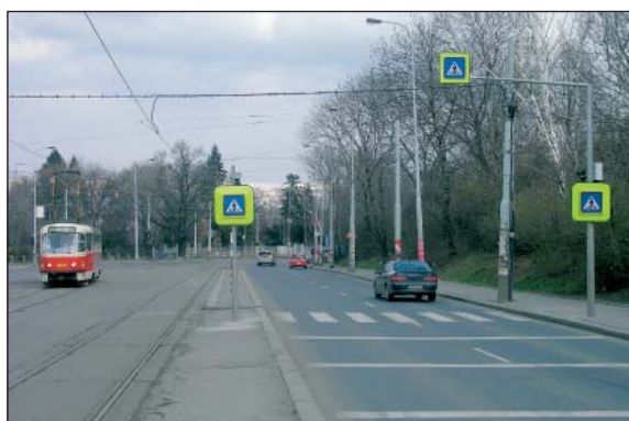
Světelné zvýraznění přechodu u zastávek MHD Vozovna Střešovice
