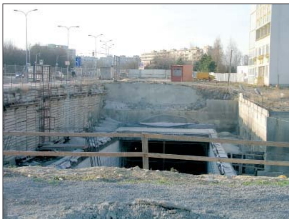
Otevřená stavební jáma metra u zastávky BUS Liberecká
