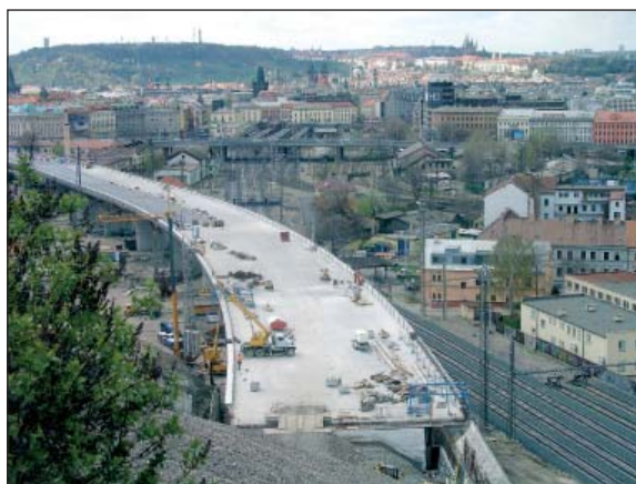
Výstavba „Nového spojení“ směrem k Hlavnímu nádraží
