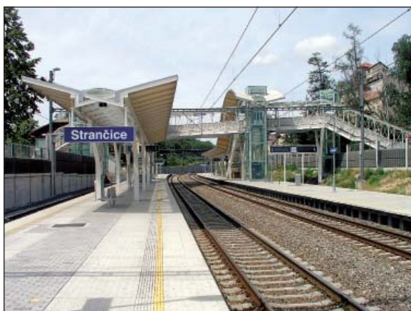
Rekonstruovaná stanice Strančice na trati 221
