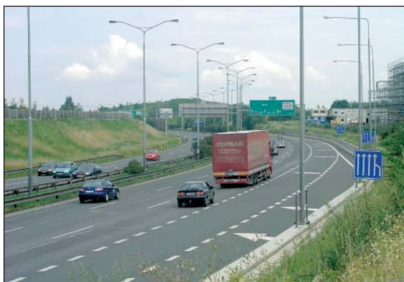
Dálnice D1 u Chodova
