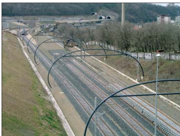
Výstavba „Nového spojení“ v oblasti Krejčárku
