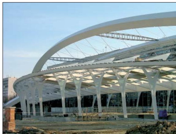
Budova stanice metra Střížkov
