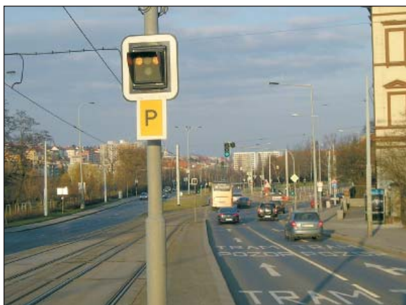
TSD 6.144 Bělohorská – Patočkova with tram presignalling
