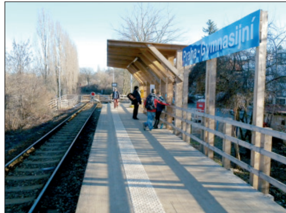
Provisional terminal stop Praha-Gymnasijní
