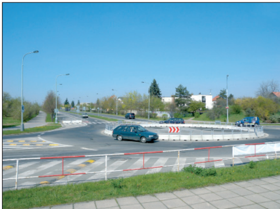
Novodvorská – Gen. Šišky – Meteorologická roundabout
