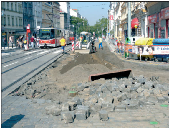
Surface replacement on Francouzská Street
