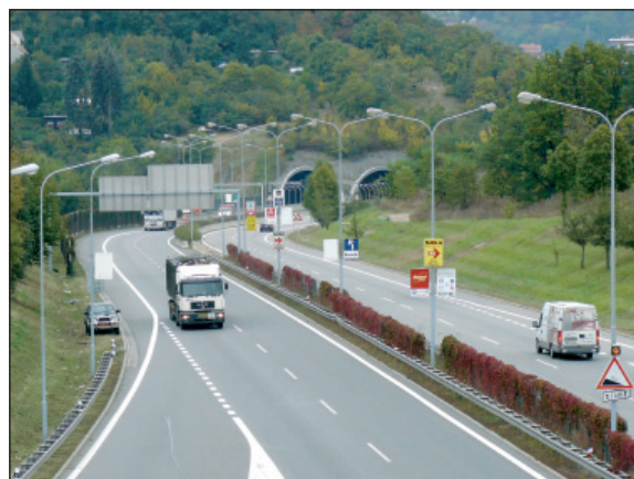
Břežská Street in Brno – Pisárky Tunnel
