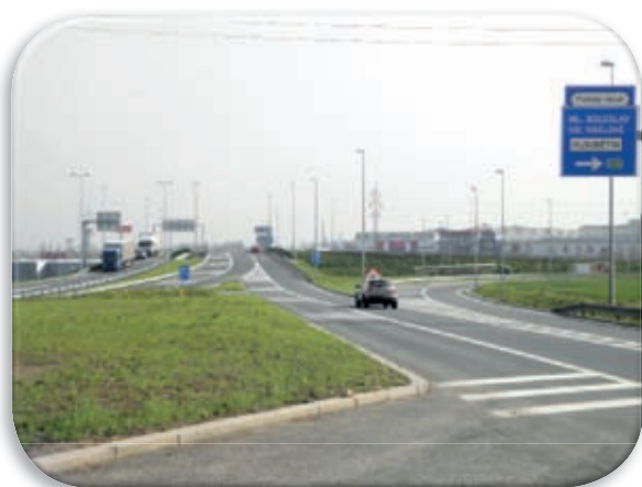
Ramps to Kbelská – Veselská interchange
