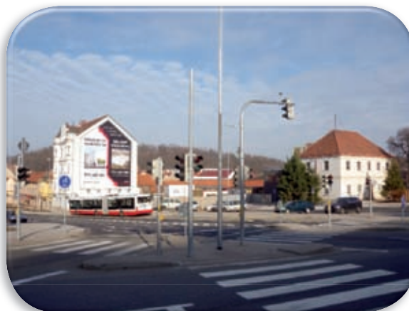
Phase III of Michelská repairs – new traffic signal at Ohradní
