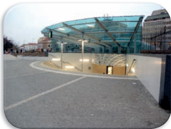
New underpass to Dejvická street
