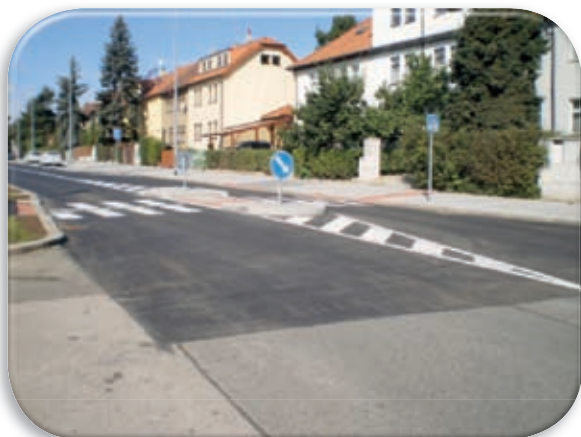
Phase II of repairs to the street Na Větrníku
