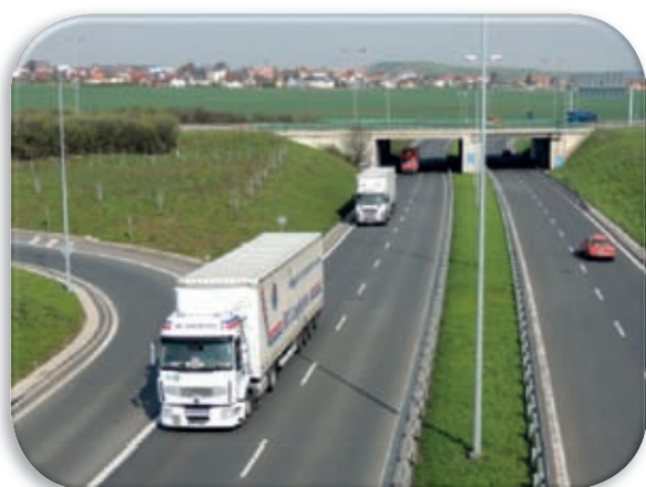
New Kbelská-Veselská interchange
