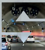
Tunelový komplex Blanka Zkušební provoz
