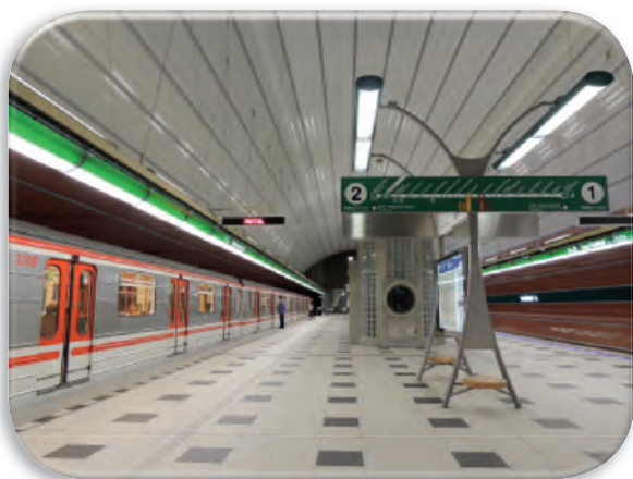
Souprava 81-71M ve stanici Petřiny
