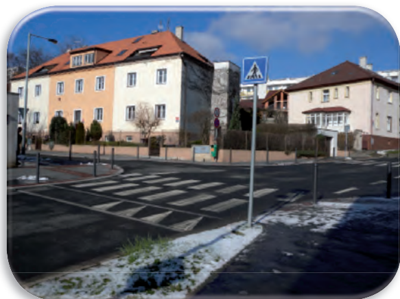
Zvýšená plocha křižovatky Na Jarově – Pod Lipami
