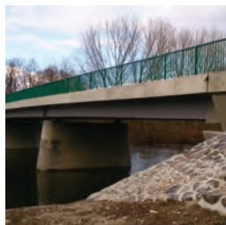
Rekonstrukce mostu přes Ohři, Břežany
