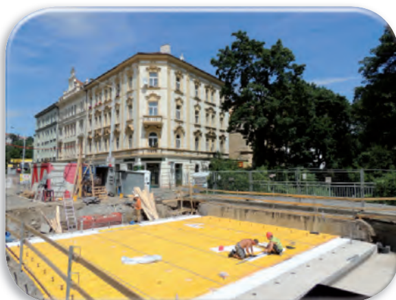
Rekonstrukce mostu přes Botič
