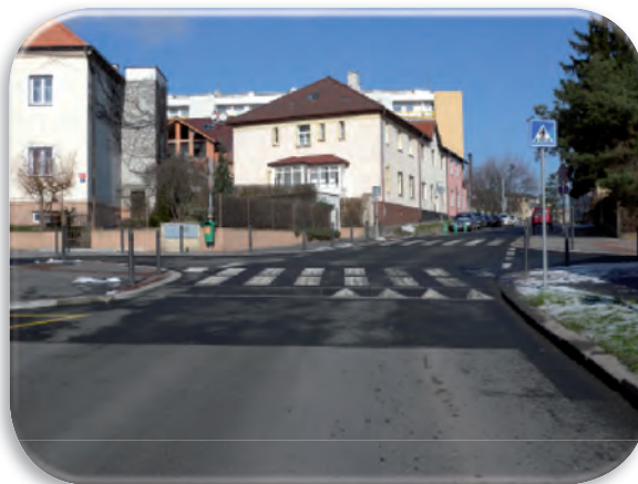
Zvýšený křižovatkový povrch na Jarově – Pod Lipami
