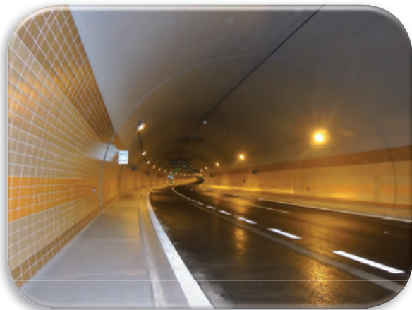
Tunelový komplex Blanka
