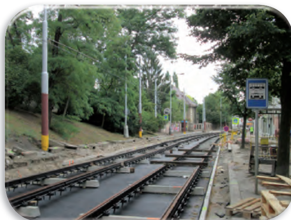
Rekonstrukce tramvajové tratě Na Zličově
