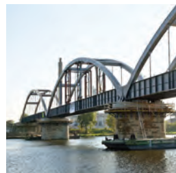
Rekonstrukce železničního mostu, trať Lovosice – Česká Lípa
