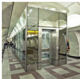
Bezbariérové zpřístupnění metra Anděl, Praha 5
