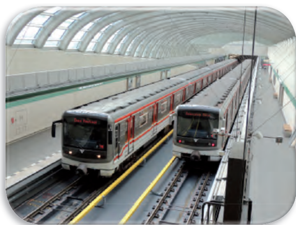
Soupravy 81-71M ve stanici Nemocnice Motol
