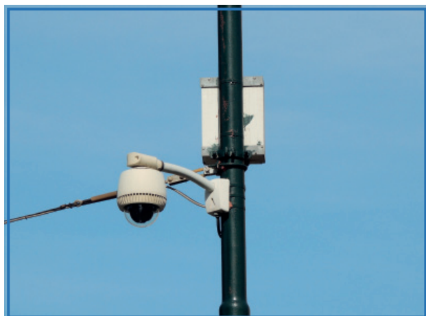
Kamera televizního dohledu na křižovatce
