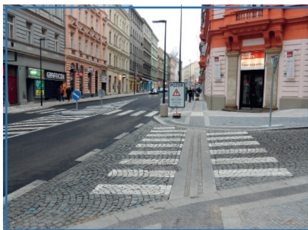
Nové chodníky a přechody v Husitské ulici
