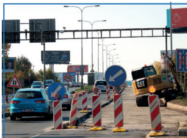
Souvislá údržba v ulici K Barrandovu
