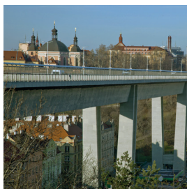
Sanace Nuselského mostu, Praha
