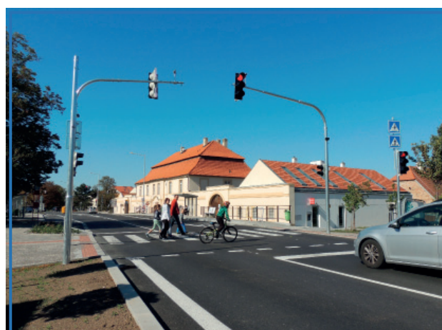
SSZ 9.611b Českokobrodská – přechod u zastávky Běchovice
