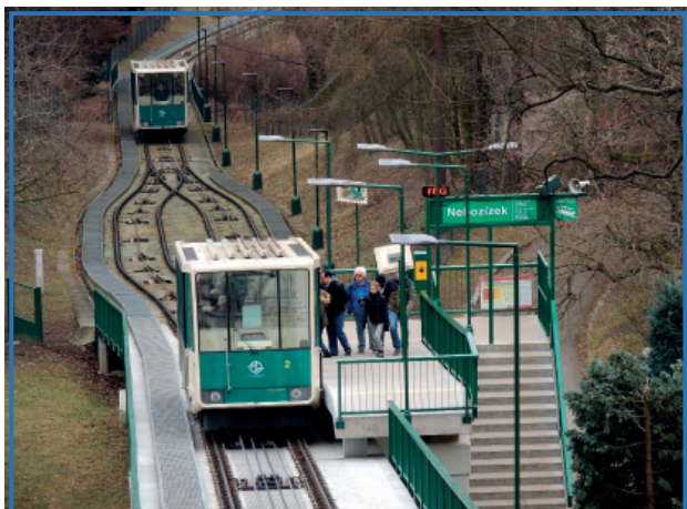
Zastávka Nebozítek na lanovce Újezd-Petřín
