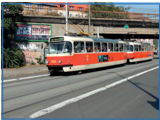
Nové tvarovky osazené v Zenklově ulici
