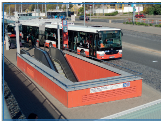
Nový eskalátor u výstupu ze stanice Nádraží Veveřavín
