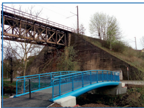
Nová lávka přes Rokytku u ulice Za mosty
