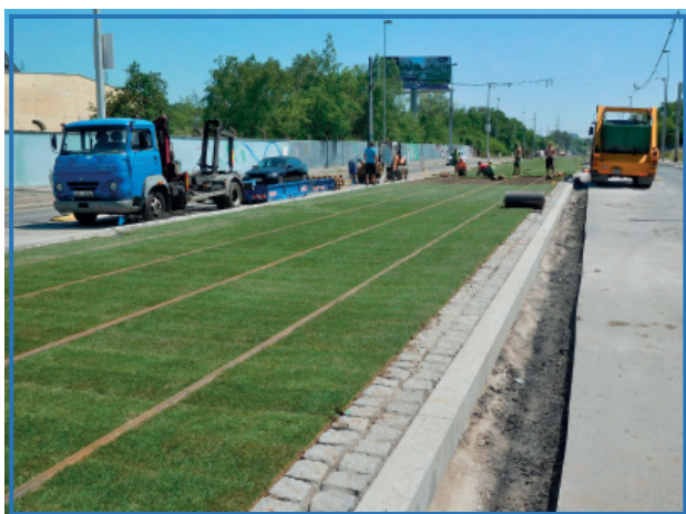
Rekonstrukce tramvajové tratě v Kolbenové ulici
