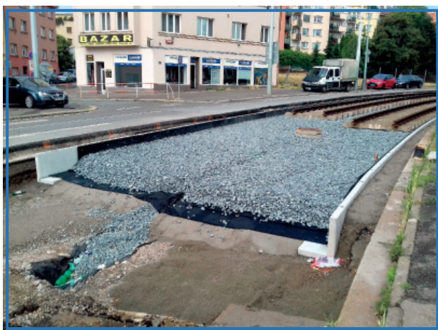
Rekonstrukce tratě na křižovatce Zenklova x Primátorská
