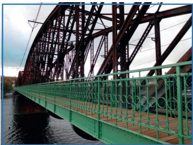
Opravená lávka pro pěší na železničním mostě na Výtoni
