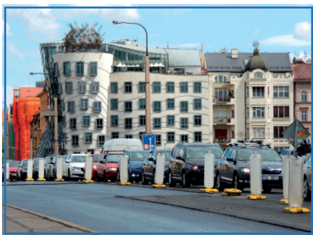
Výměna povrchů vozovek na Jiráskově mostě
