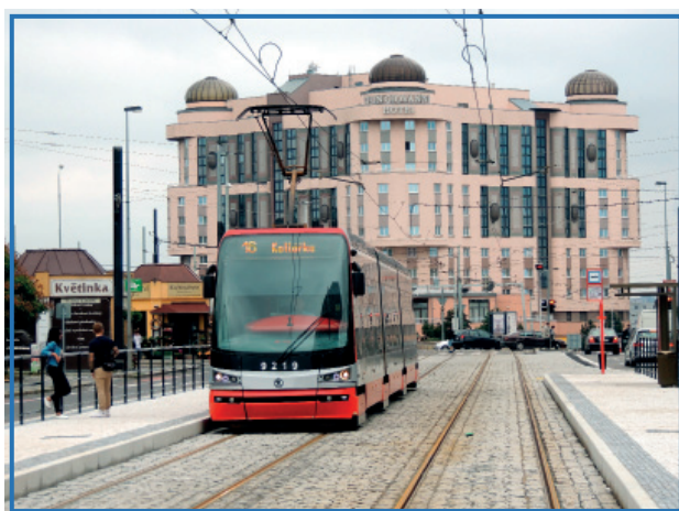
Tramvajová trať ve Vinohradské ulici po rekonstrukci
