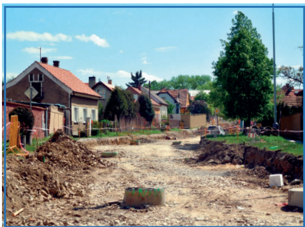
Průběh rekonstrukce Libušské ulice v Písnici
