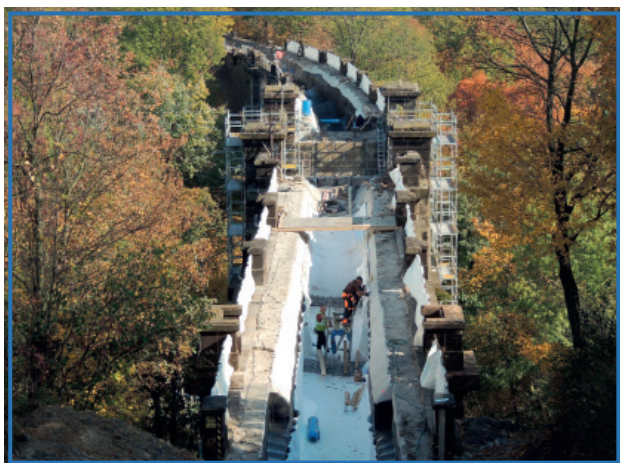
Jeden z rekonstruovaných viaduktů v Hlubočepích
