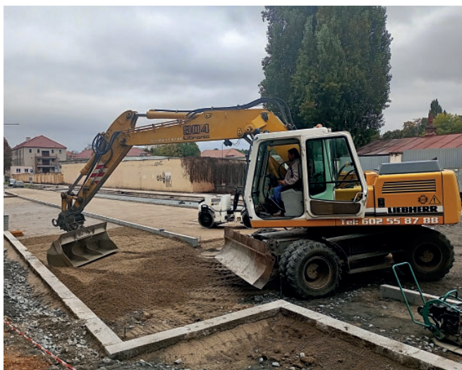
■ Průběh rekonstrukce ulice
