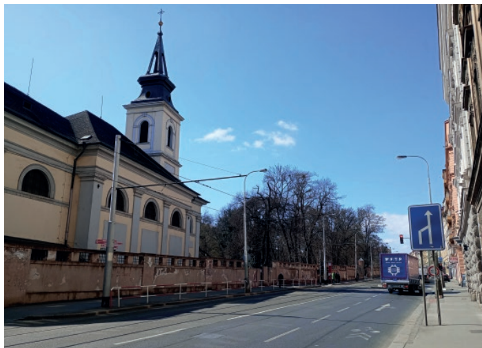
■ Vozovka po provedené souvislé údržbě v blízkosti kostela Nejsvětější Trojice
