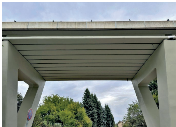
■ most K Tuchoměřicům po sanaci
