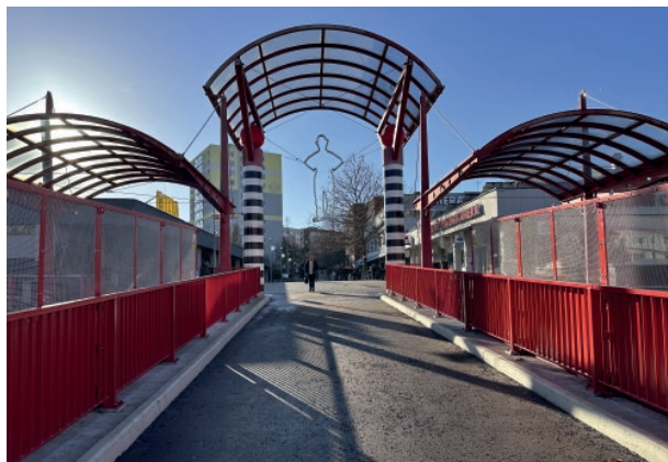
■ Lávka přes Lamačovu ulici
