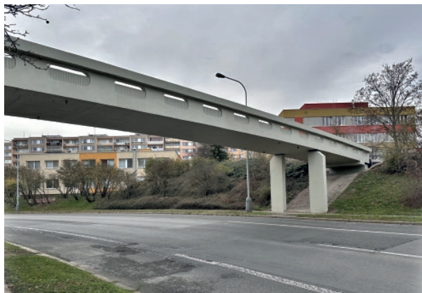
■ Lávka přes Oistrachovu ulici
