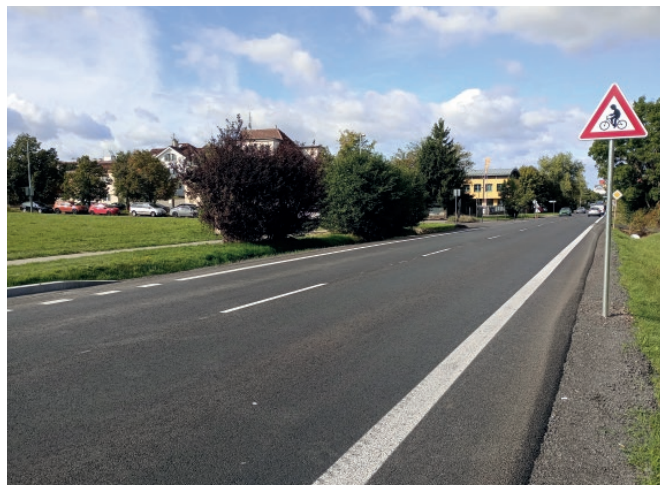
■ Ulice po dokončení oprav
