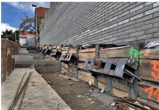
■ Stabilizace svahu pro chodník Pod Bateriemi
