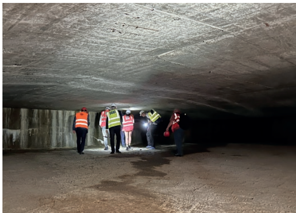
■ Podzemní prostory pod mostem X675 Legerova
