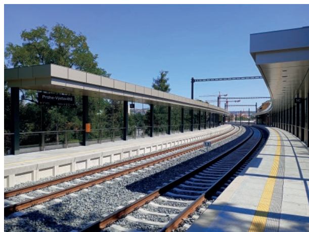
■ Nová zastávka Praha-Výstaviště
