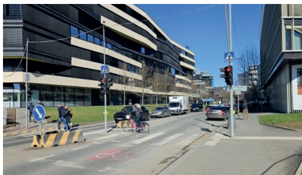
■ Nové provizorní SSZ 8.985 Voctářova – přechod Boudníkova
